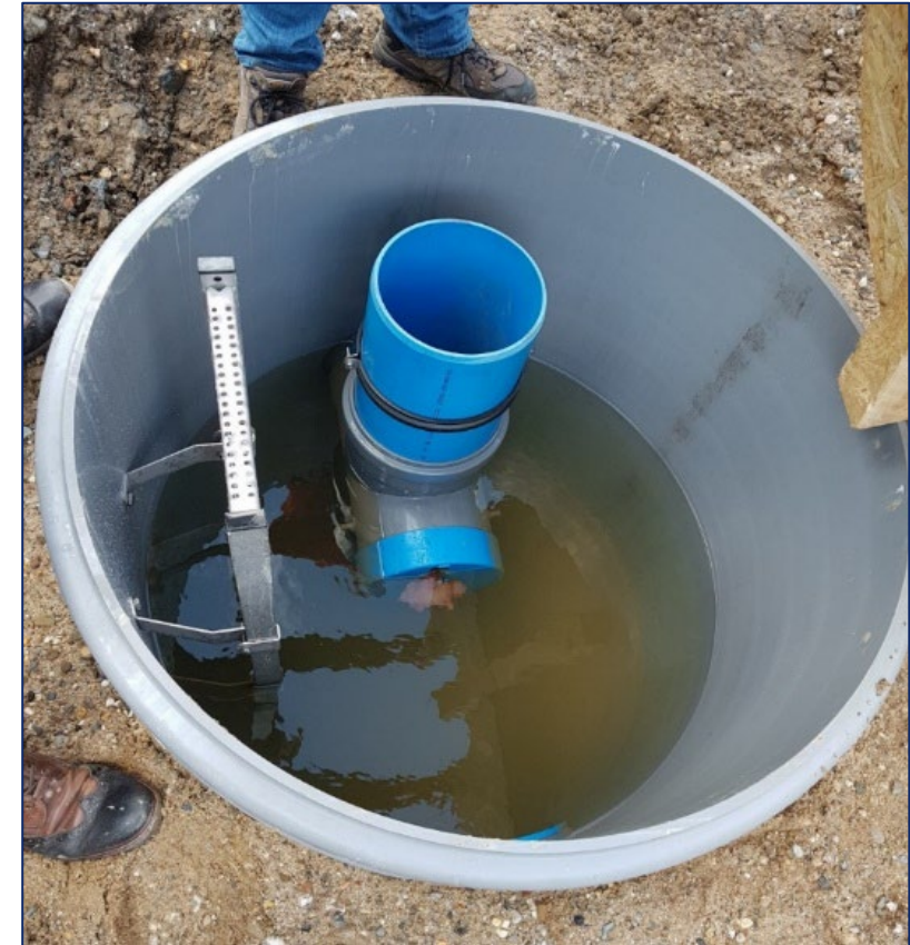
Herstellung Rigolen / Baumrigolen, Drosselschacht
