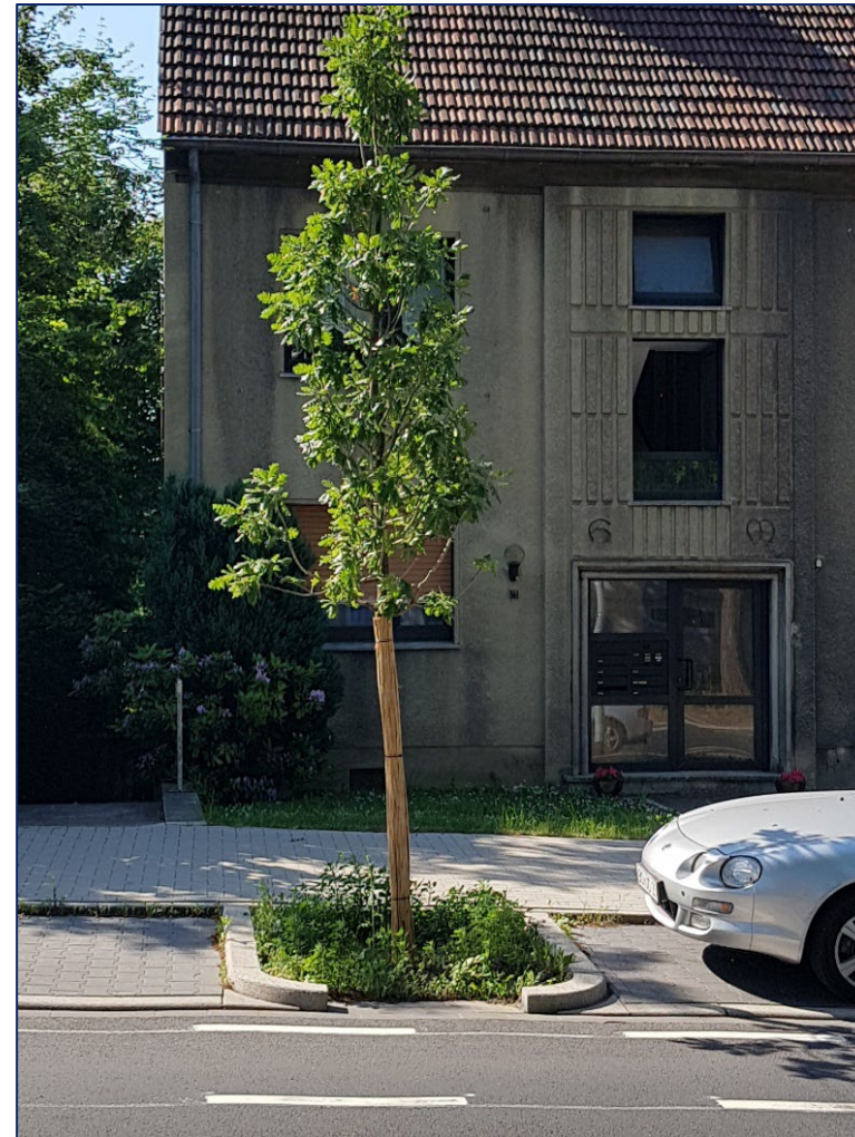
Fertiggestellte Baumrigole
